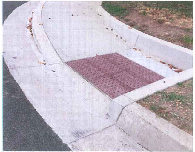
New ADA Ramp
